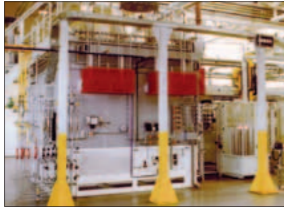
Drehherdofen mit Kühlsystem, Begasungsarmatur und Härtepresse
