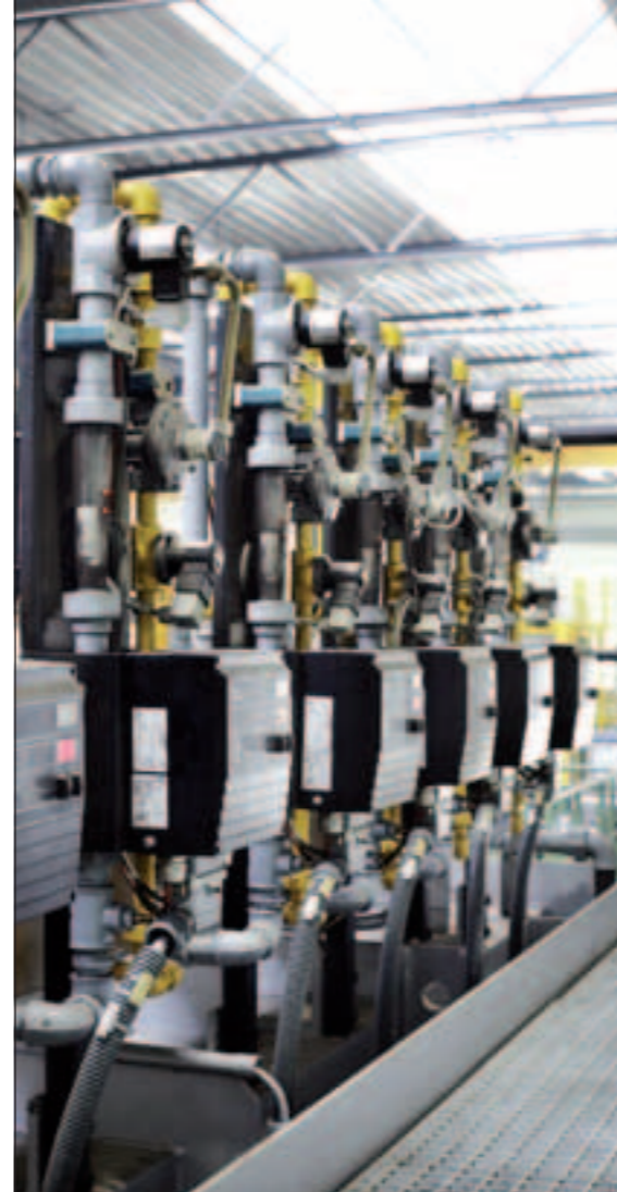
Recon® 加熱装置の混合バ テリーと電子制御
